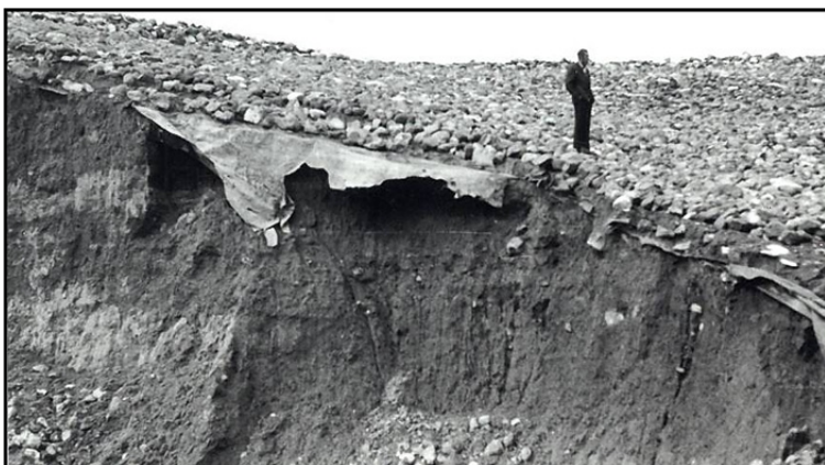
Рис. 7. Порванная полиэтиленовая пленка на месте прорыва плотины (фото В. Бойнагряна).
